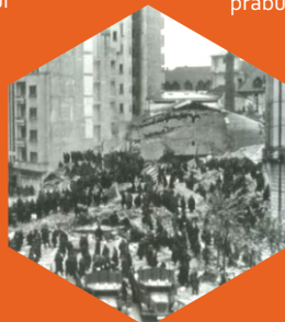
Blocul Carlton prăbușit la cutremur
